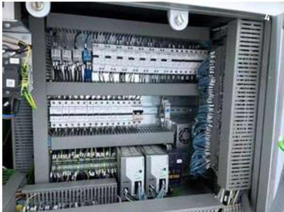
Fig. 4 Dettaglio di parte dell'impianto elettrico necessario al funzionamento di un sistema robotico. È evidente la complessità di integrazione.
